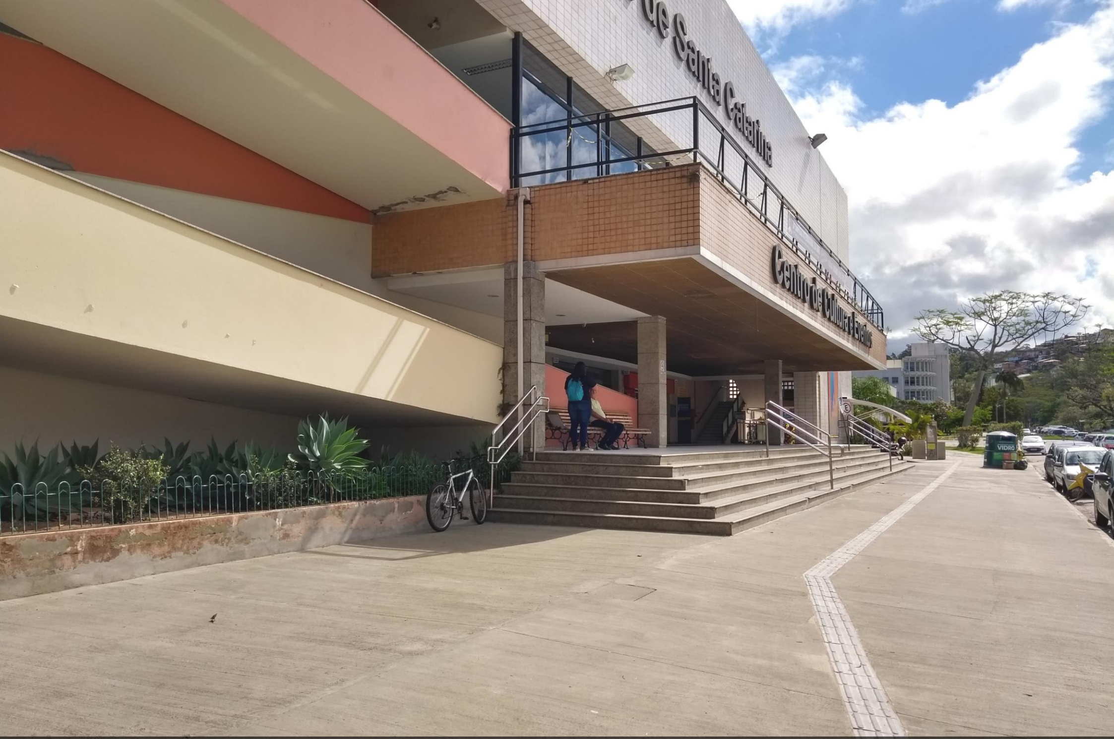
ACESSO À PRAÇA DA CIDADANIA – APÓS OBRAS
