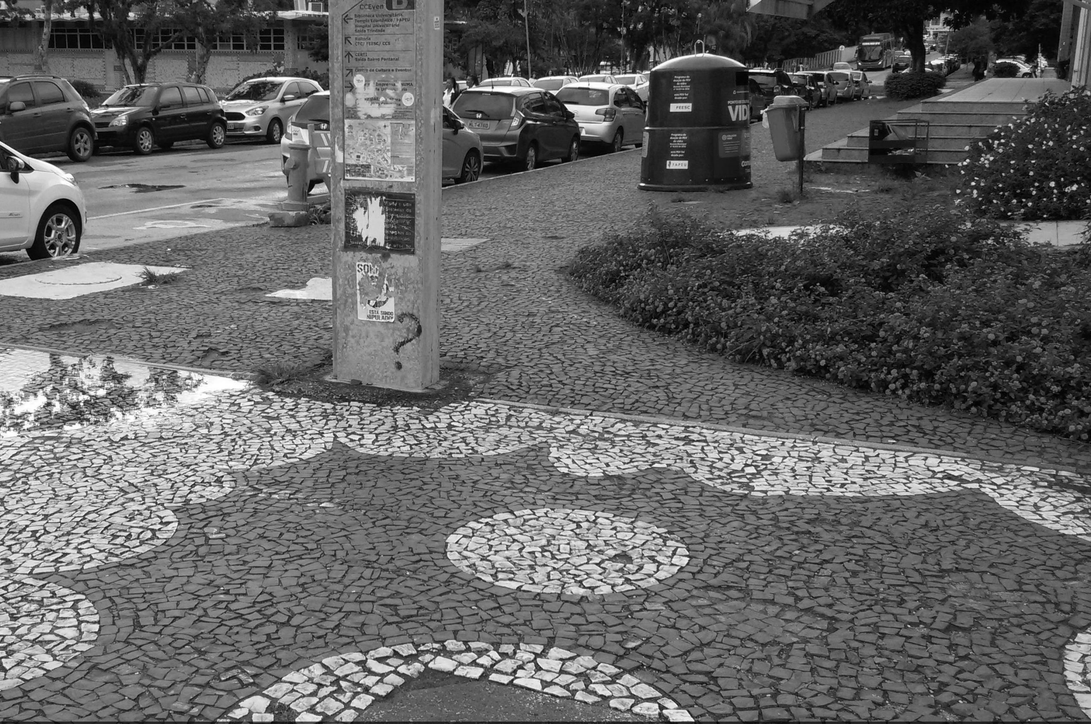
CALÇADA CENTRO DE CULTURA E EVENTOS - ANTES
