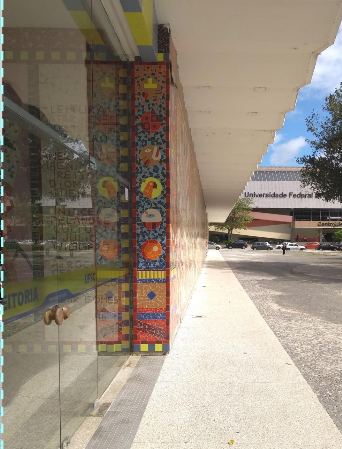
PRAÇA DA CIDADANIA – EM OBRAS
