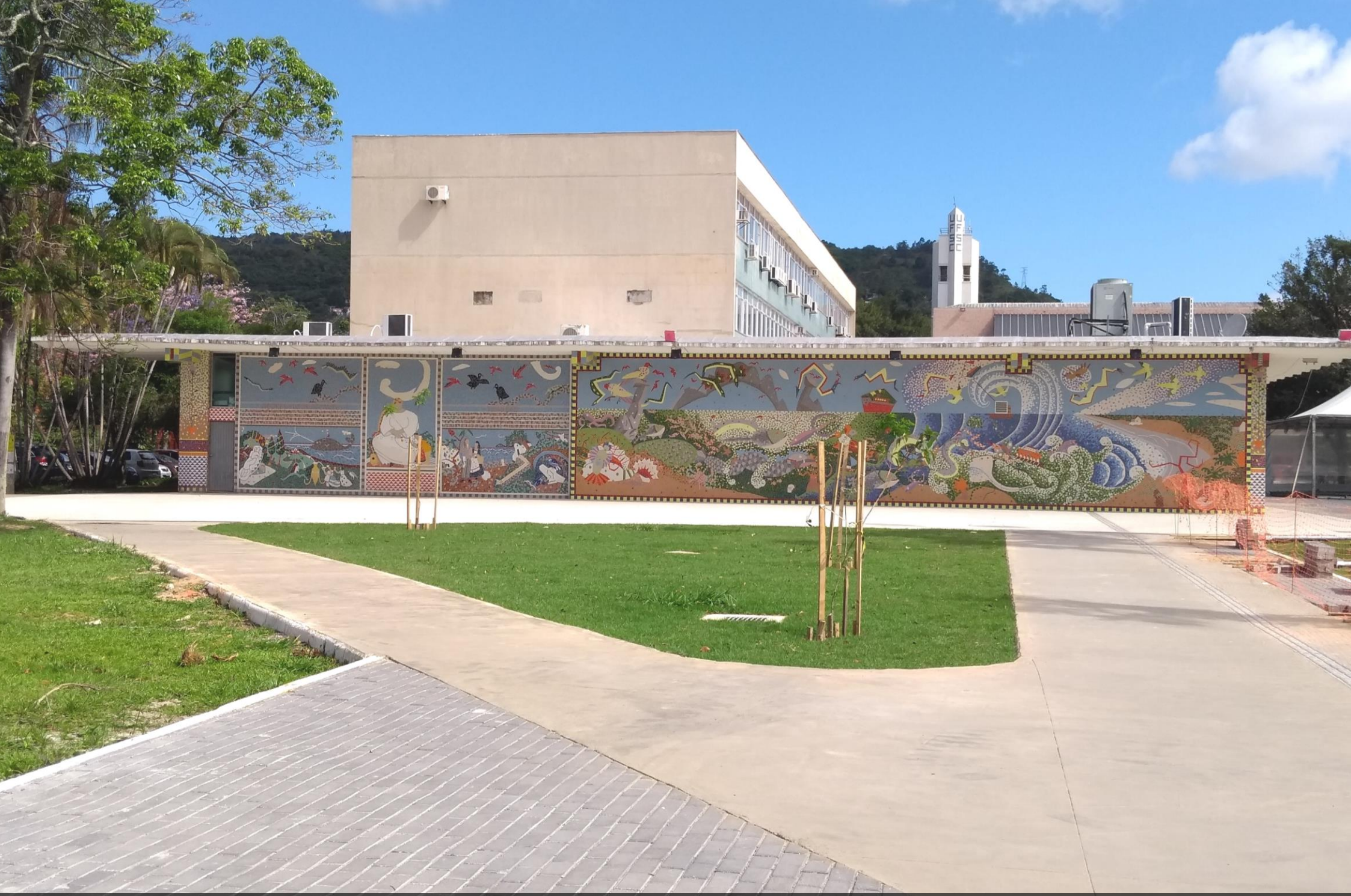
ACESSO À PRAÇA DA CIDADANIA – EM OBRAS
